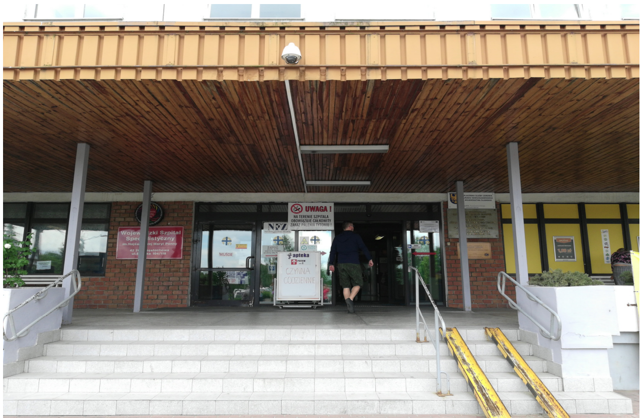
Wejście główne do budynku
